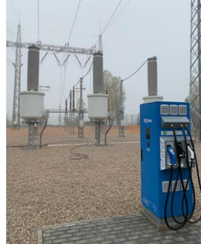
▲ Tecnologia inovadora desenvolvida pela REN vai permitir ter postos de carregamento elétrico de baixa tensão ligados à rede de alta tensão no espaço florestal.
